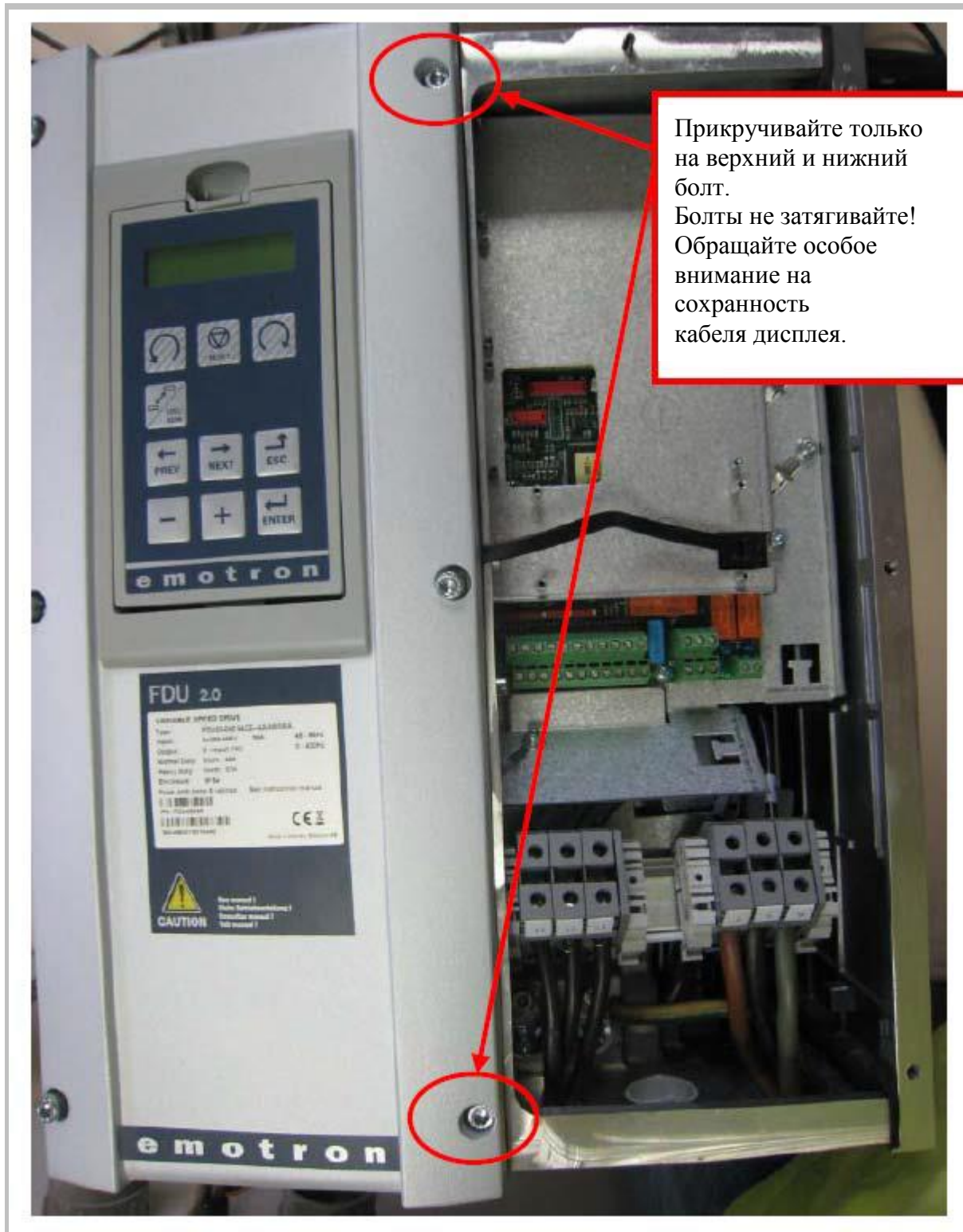
Рис.4 Размещение передней крышки и подключение дисплея преобразователей частоты серии VFX48-... при выполнении пусконаладочных работ.
